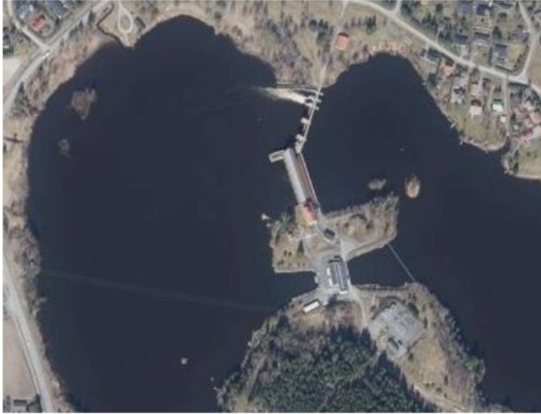
Kuva 25. Äetsän uusi voimalaitos on rakennettu joen etelärannalle, vanha voimalarakennus on joen keskellä. Kuvassa näkyy ohijuokсутusta säännöstelypadosta pohjoisrannalla
