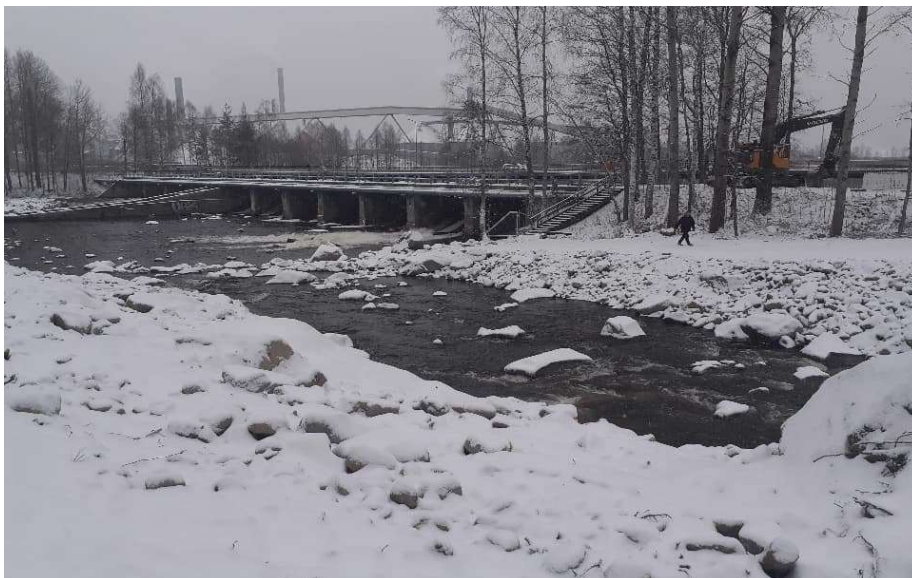
Kuva 12. Varkauden Ämmäkosken ohitusuoma, joka ohittaa taustalla näkyvän säännöstelypadon. Kuva: Jukka Jormola
